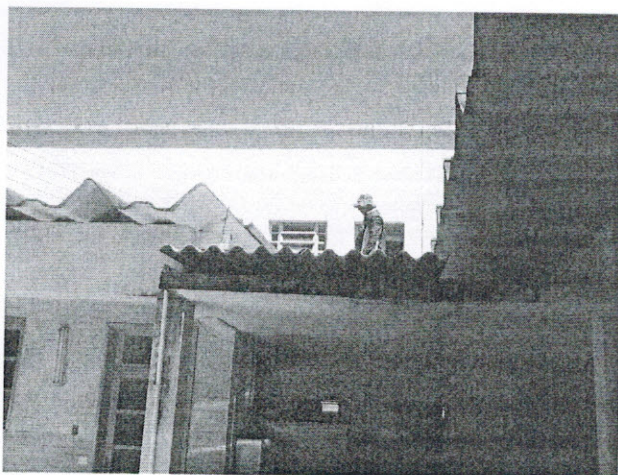
FOTO 05- Limpeza em calhas e telhados.
