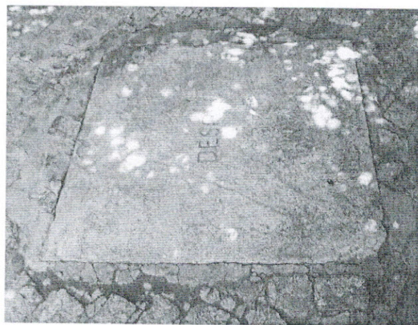
FOTO 03- Colocação de tampas em caixas de esgoto.
